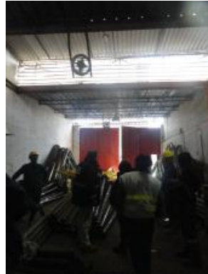
Foto No 10 En el techo se observa uno de los dos extractores de aire, los cuales no son suficientes ya que la cantidad de material particulado en el aire es excesivo. La iluminación y ventilación son deficientes
