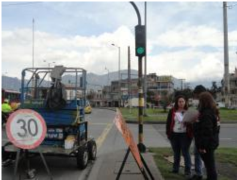
Foto No 13. Lavado y pintura de postes en la carrera 30 con calle 8ª sur. Se observa la señalización del PMT y la plataforma elevadora.
