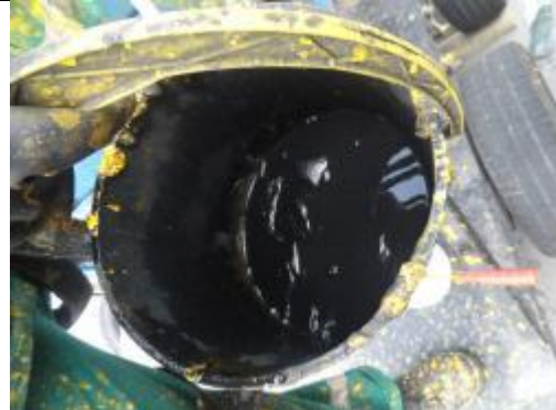
Foto No 16 Caneca donde se enjuuga el trapo con el cual se limpian los postes. El agua está totalmente sucia lo que impide una adecuada limpieza.
