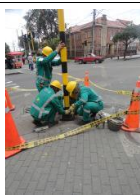
Foto 6 Instalación y anclaje del poste tipo mástil T1 por parte del personal del Contratista Tevaseñal S.A.
