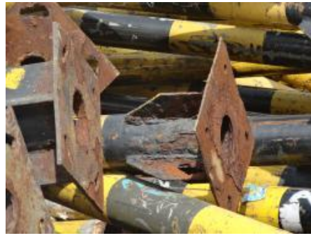
Foto 2. Detalle del estado de deterioro en que se encuentran los postes, que van a ser retirados por la Asociación de Recicladores Eco Activa para su disposición final.
