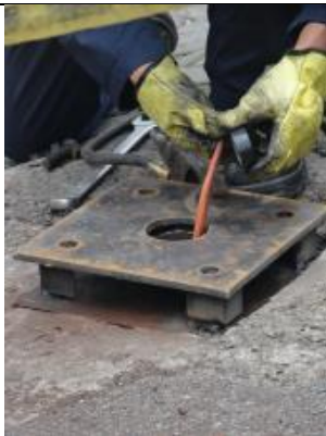
Foto 5. Instalación del realce de la platina base y manipulación del cable eléctrico del semáforo a través del orificio para posteriormente llevarla a través del poste hasta el semáforo.
