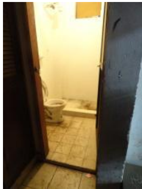
Foto No 10 Las condiciones de aseo y salubridad del baño son deplorables.
