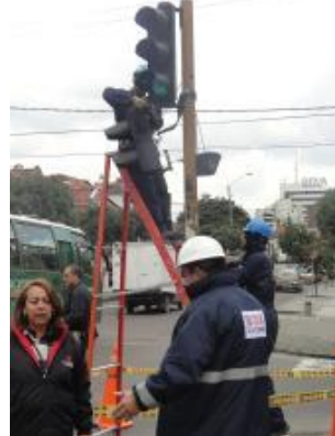
Foto 4. Desmante del semáforo por parte del personal de la ETB (Contrato 20131786), previo a la instalación del nuevo poste de mástil T1
